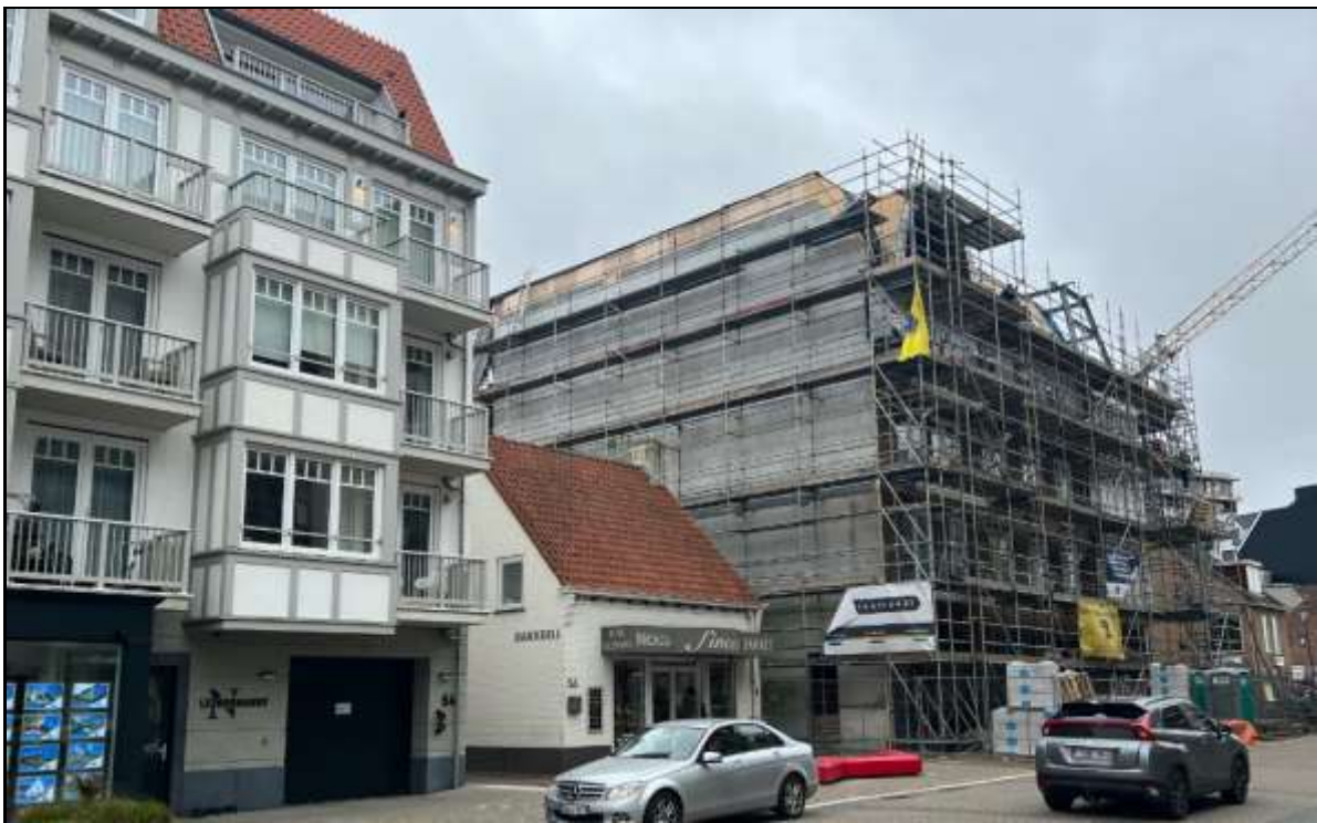
Figuur 4: Boulevard de Wielingen 57A in aanbouw rechterzijde
