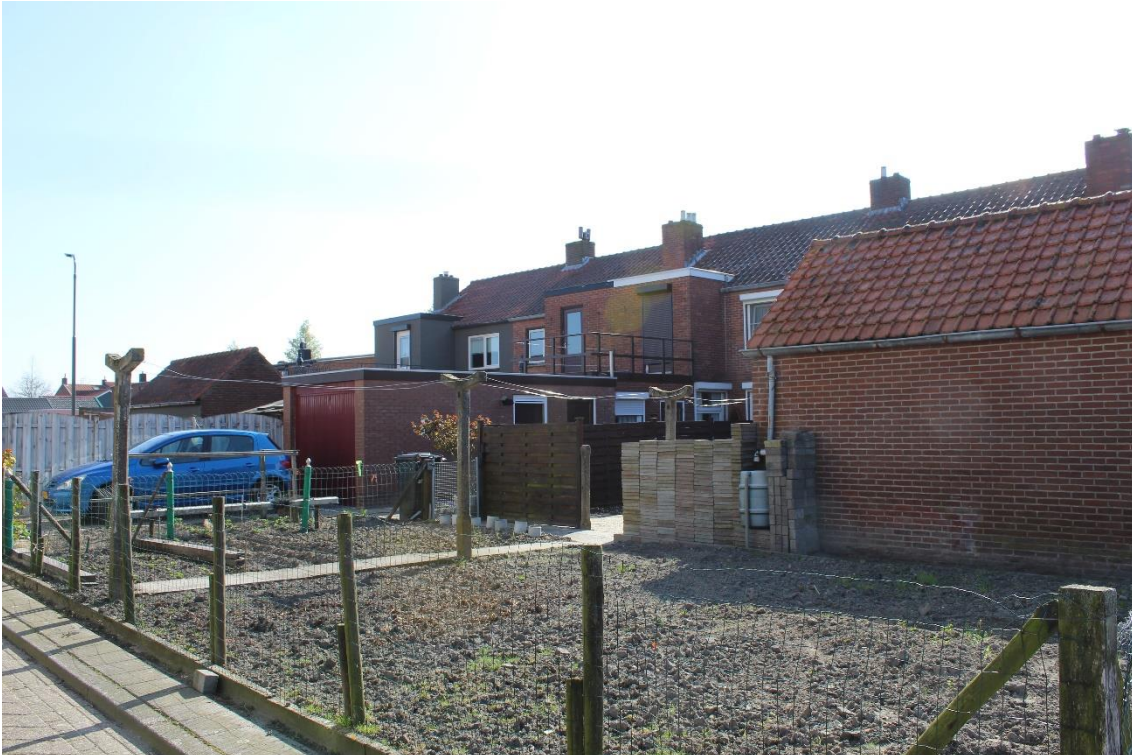
Achterkant woningen oostelijk blok Burgemeester van Houtestraat
