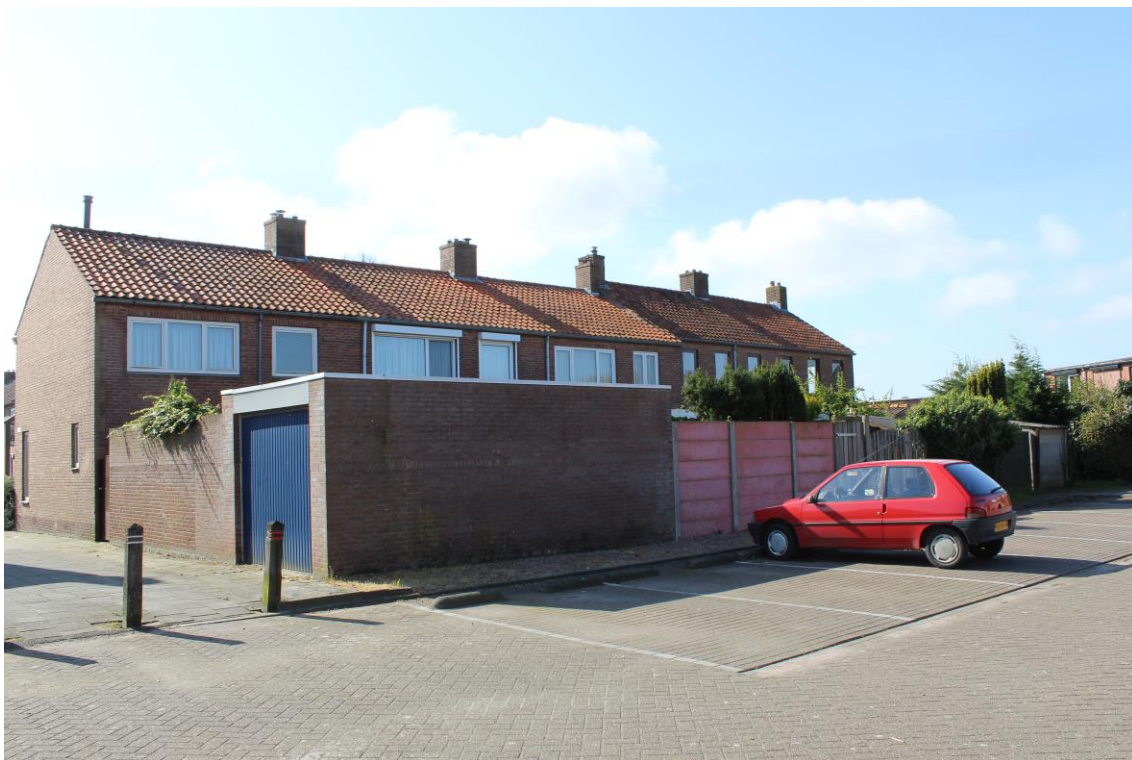
Achterkant westelijke blok woningen aan Burgemeester van Houtestraat
