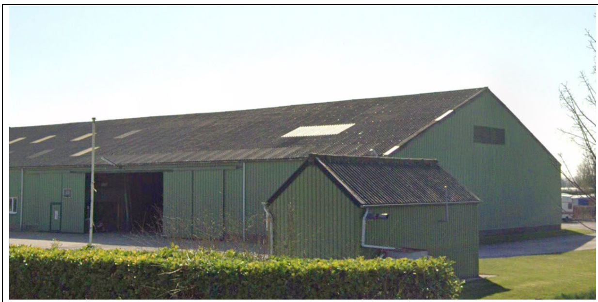
Figuur 3. Te slopen gedeelte van de loods
