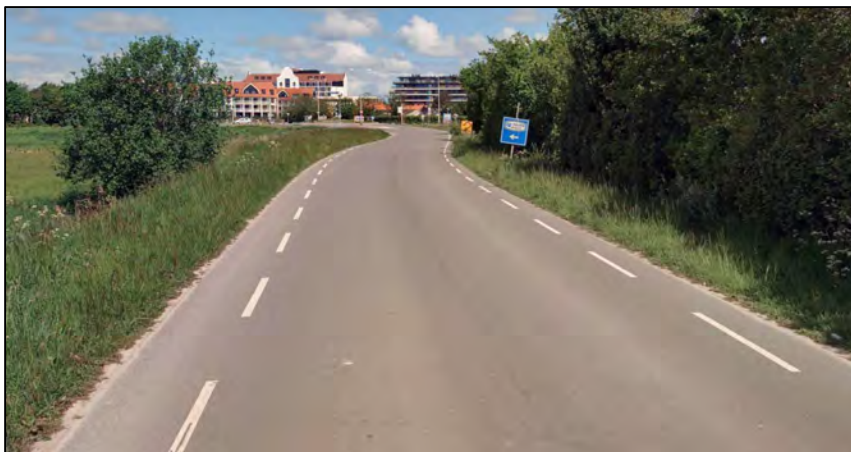
Figuur B1.3: Locatie 2 - Ringdijk Noord II, ten zuiden van de Tienhonderdsedijk
