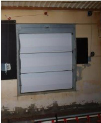
Voorbeeld van lamellen (Louvre-systeem) in zijgevel en luchtopvang in de nok.
