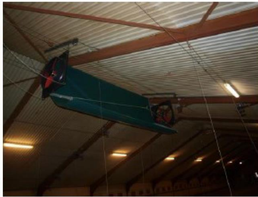
Voorbeeld van lamellen (Louvre-systeem) in zijgevel en luchtopvang in de nok.
