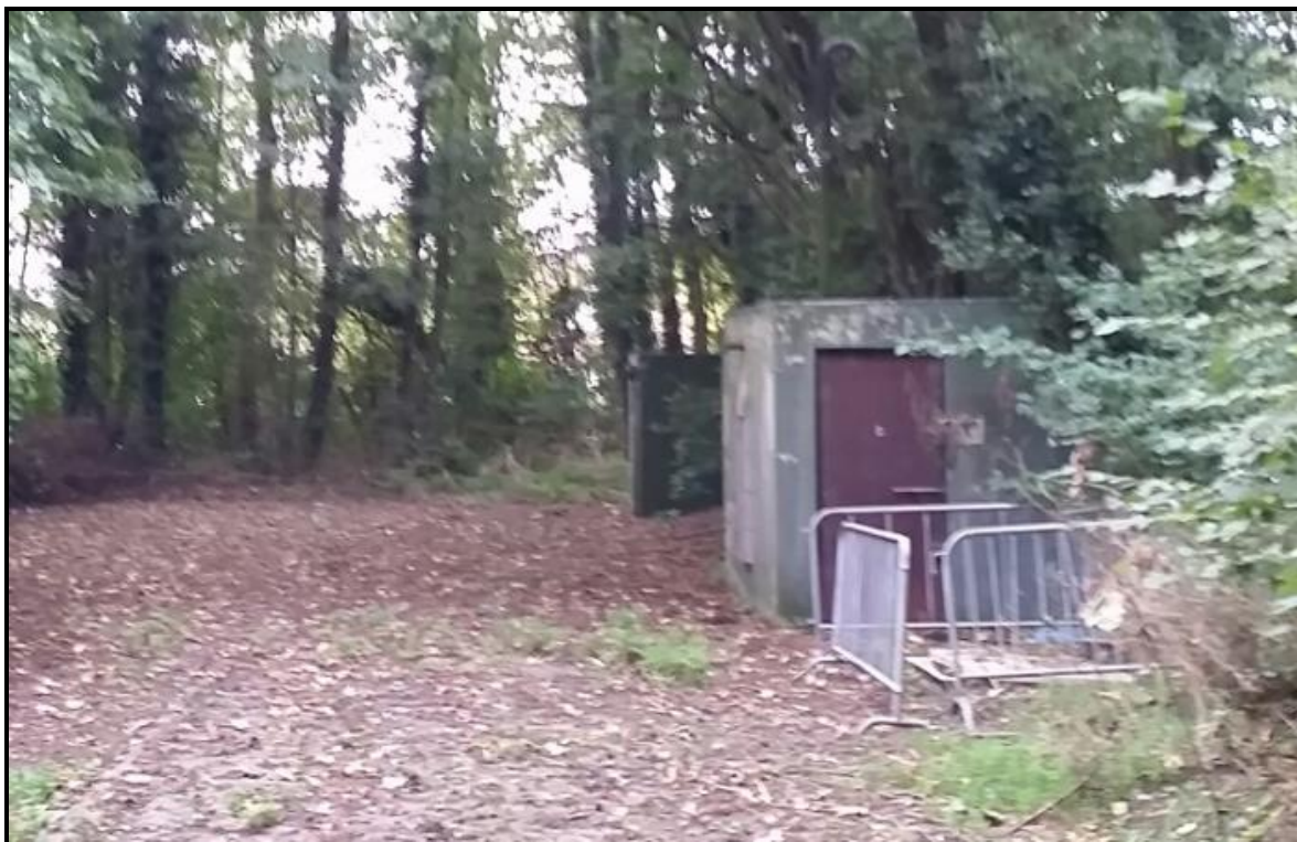
Figuur 5: Bestaande situatie boven maaiveld (foto 2017)
