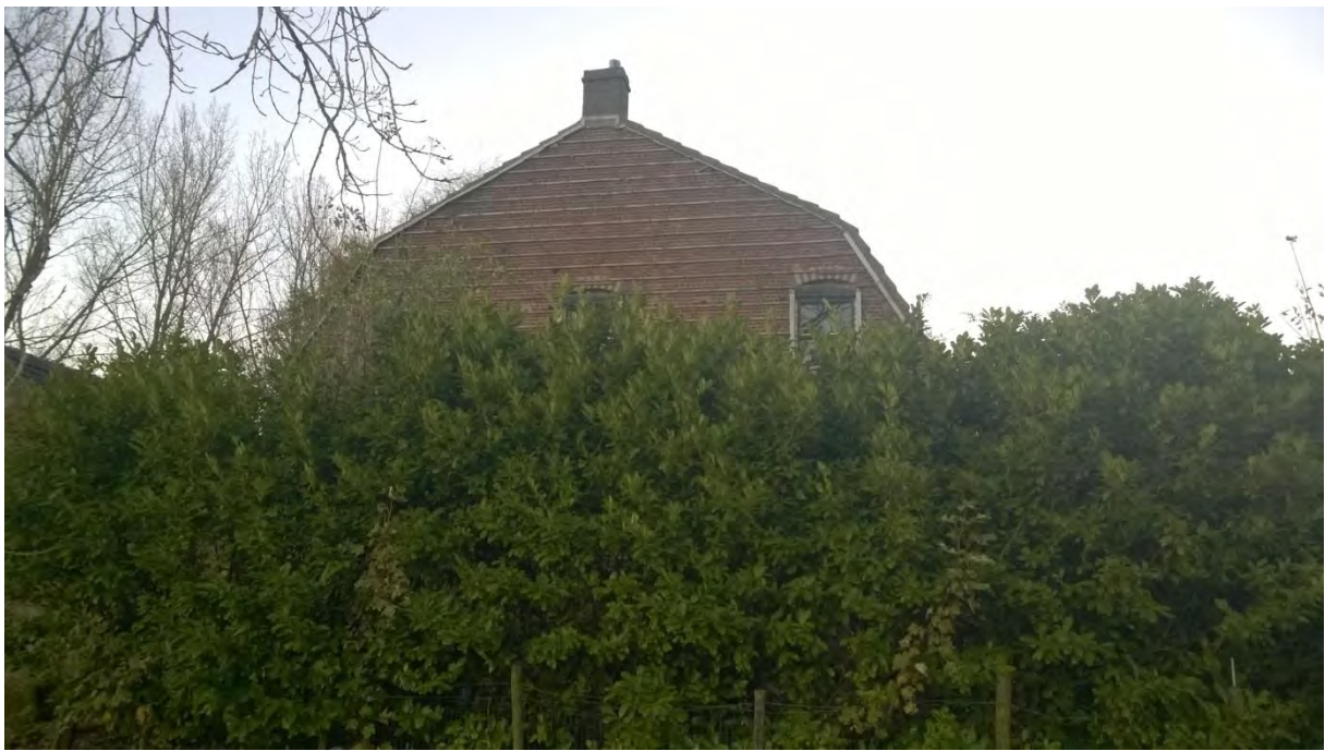
Foto 6. Gevelbekleding westzijde woning verwijderd
