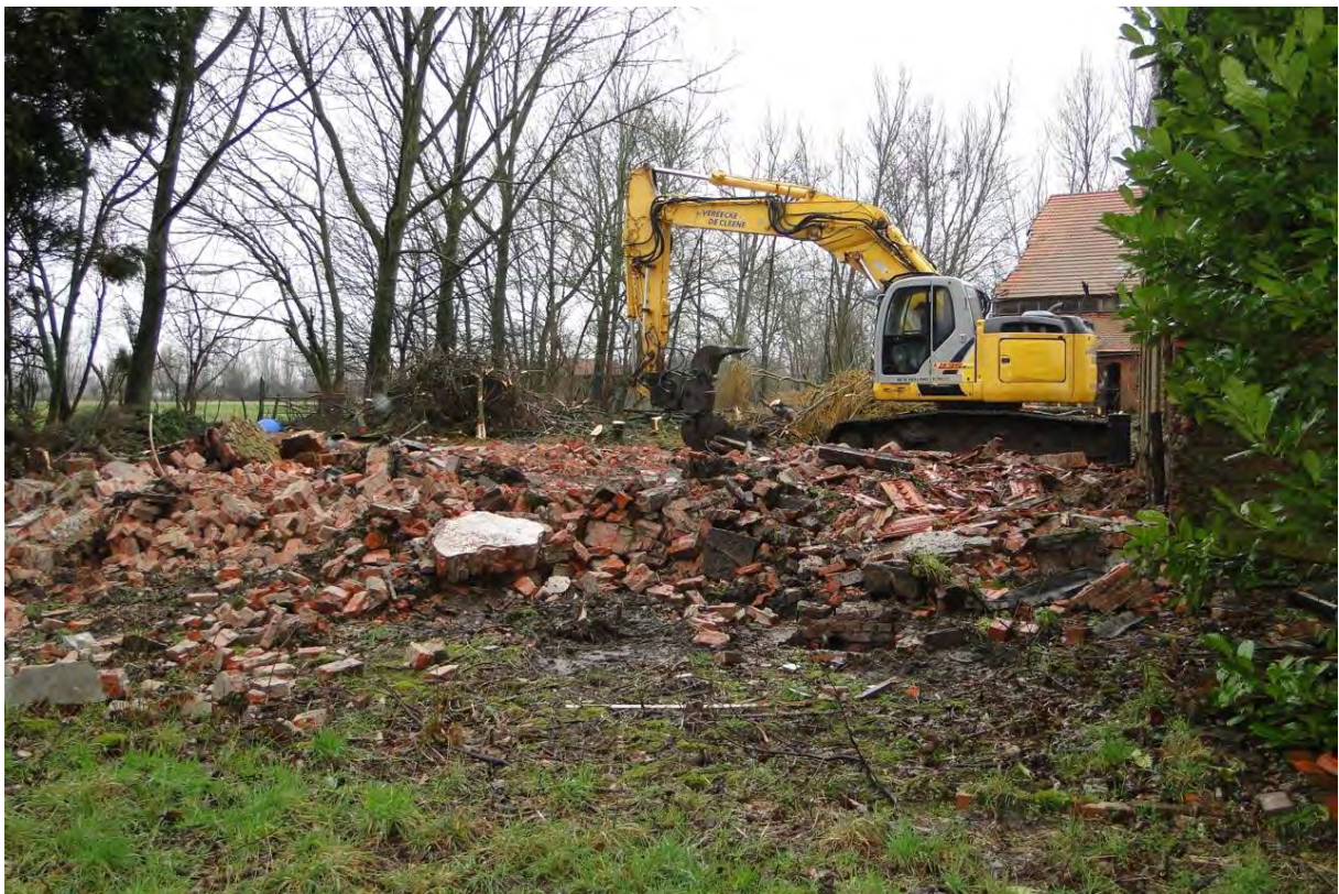
Figuur 5. Sloop van de bestaande bebouwing
