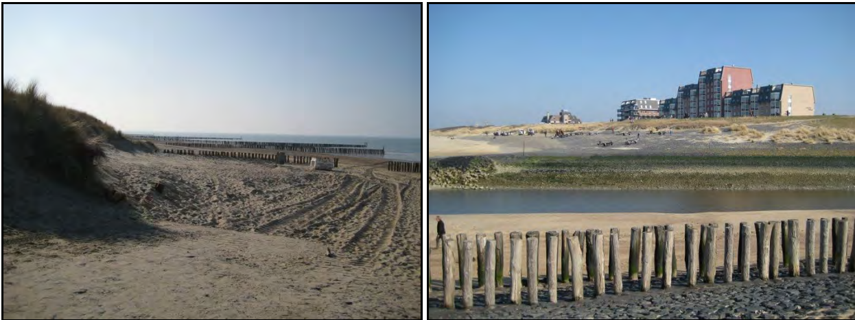
Figuur 5.2 Gloomig ten westen van het gemaal (links) en glooiing ten oosten van het gemaal (rechts)
