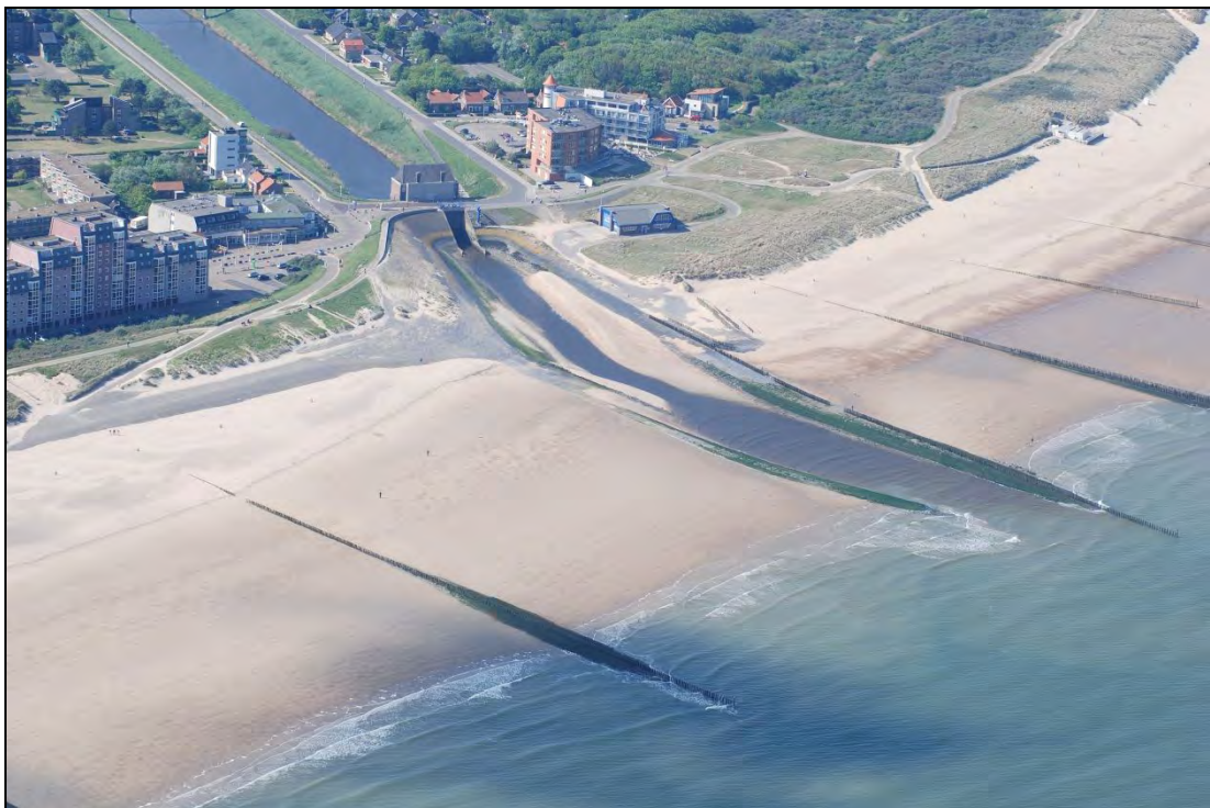
Figuur 1.3 Luchtfoto gemaal en strekdammen vanaf zee [Waterschap Scheldstromen, 2011]
