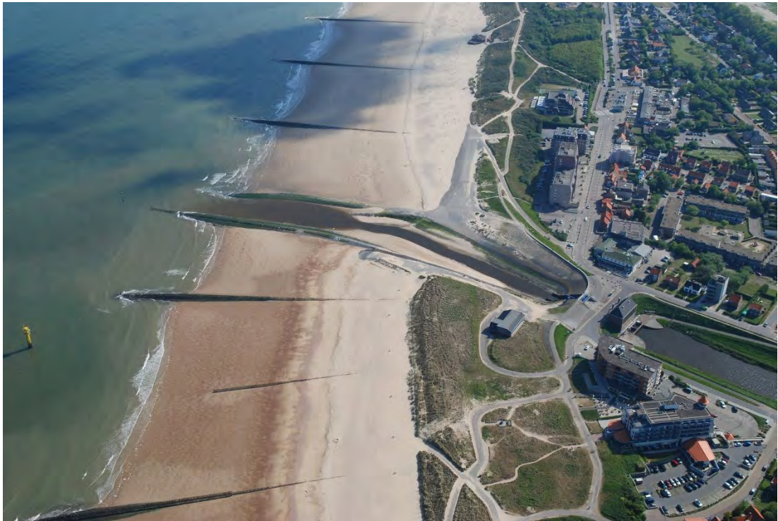
Figuur 1.2 Luchtfoto gemaal en strekdammen [Waterschap Scheldstromen, 2011]
