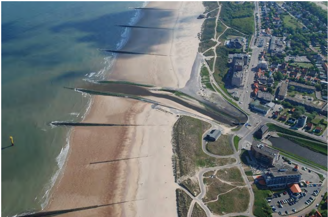
Figuur 2.1 Luchtfoto gemaal en strekdammen [Waterschap Scheldestromen, 2011]
