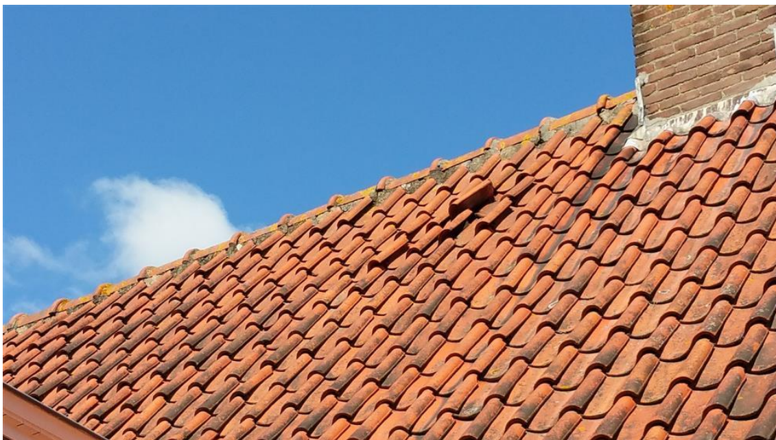
Figuur 2 Loszittende dakpannen bieden gierzwaluwen en vleermuizen toegang onder de dakpannen.
