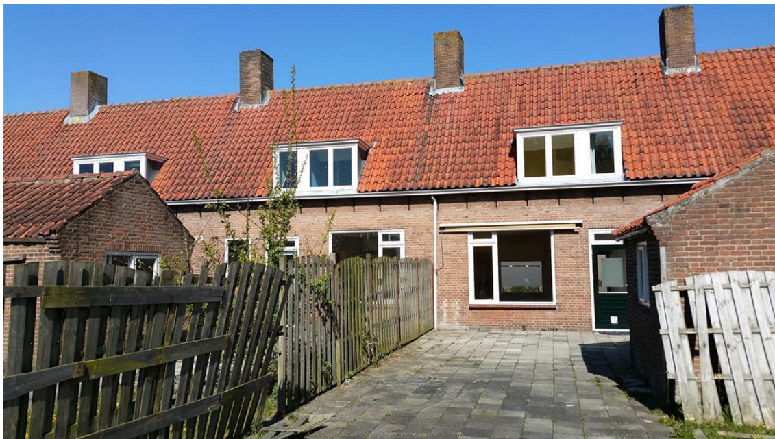
Figuur 3 Holle dakpannen bieden huismussen toegang onder de dakpannen.
