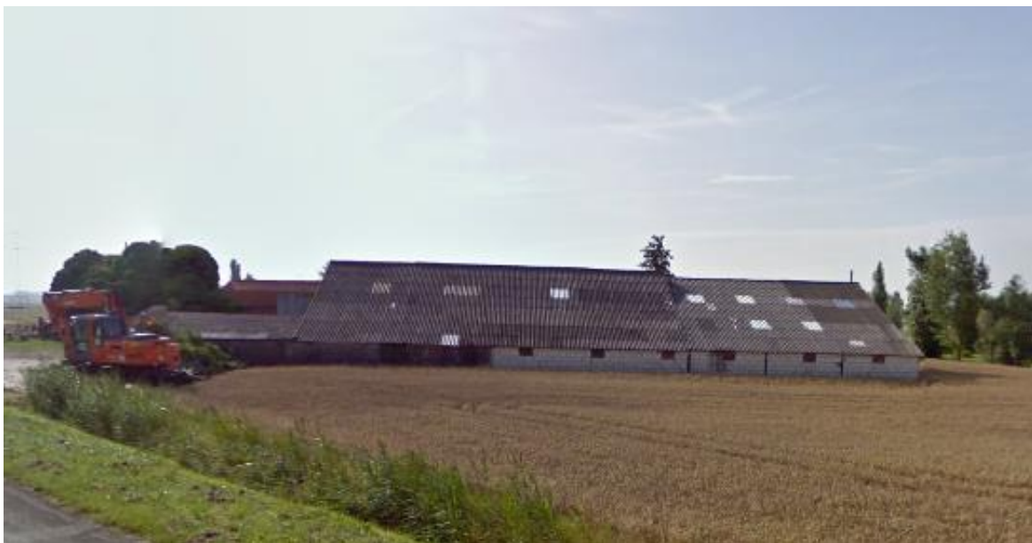
Figuur 2: Foto's bestaande situatie
