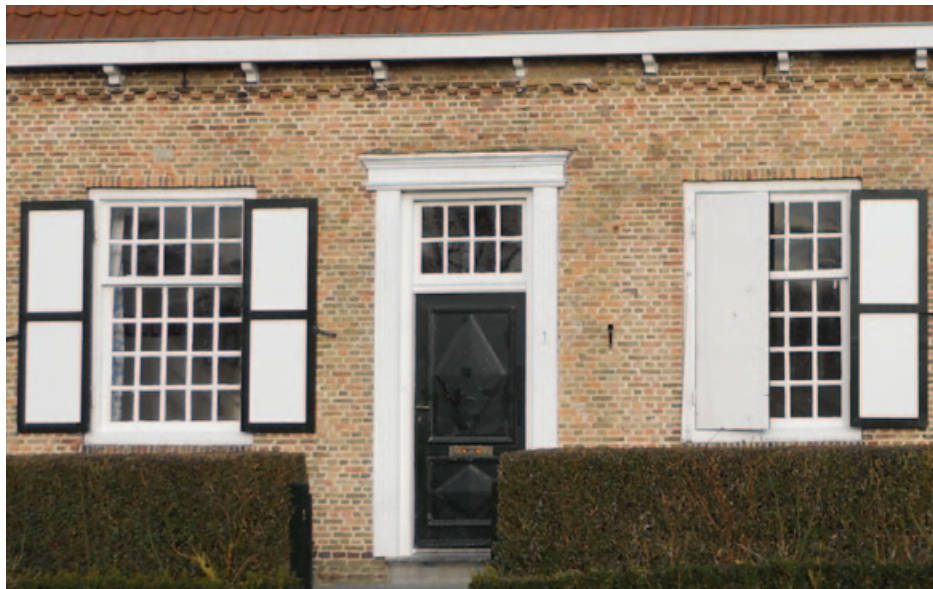
lichte kleurstelling ramen en deuren
