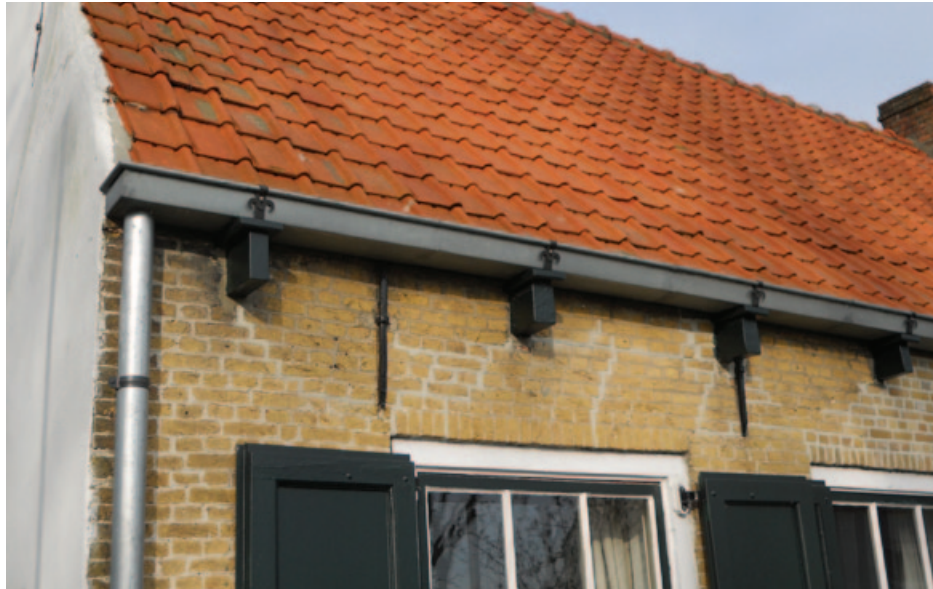
gootklossen en muurankers
