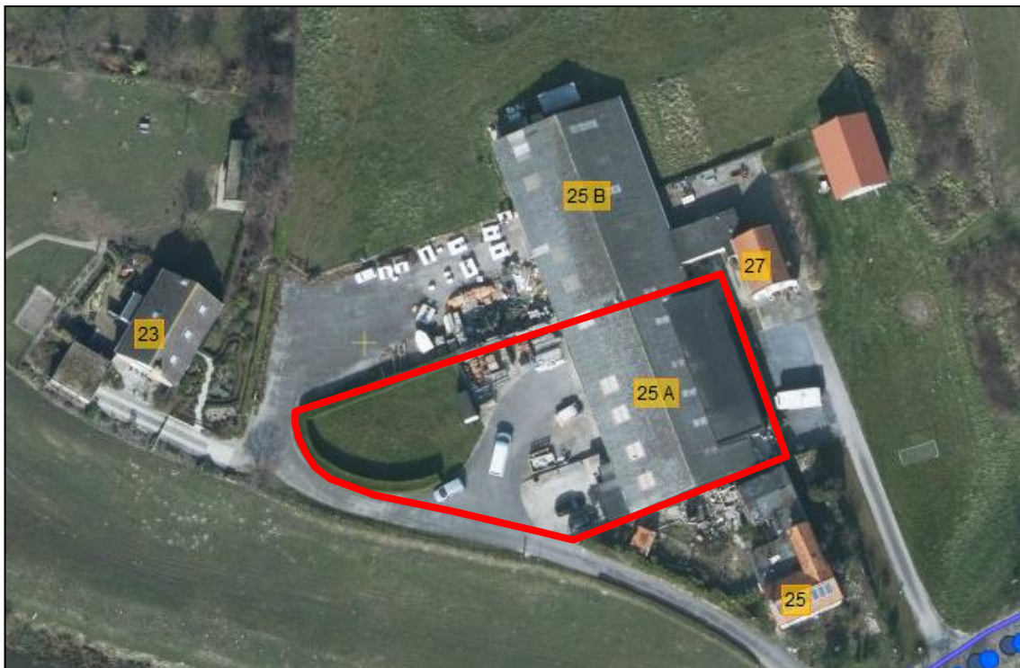
Satellietfoto ter plaatse van het bebouwingscluster aan de Molenstraat, ten oosten van de vestingwerken van Retranchement. Per hoofdgebouw is het huisnummer weergegeven. Het plangebied is indicatief weergegeven met een rode contour.
