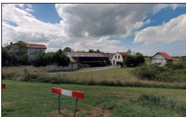
Aanzicht van de oostzijde van de loods, gezien vanaf de Molenstraat. Op de voorgrond is het voorerf van de belendende woning aan de Molenstraat 27 zichtbaar.
