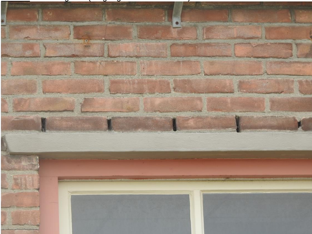
Foto 3. Ventilatiegaten (toegang voor vleermuizen).
