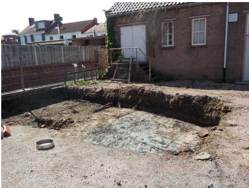
Foto 5. Ontgravingsput van de met asbest verontreinigde grond
