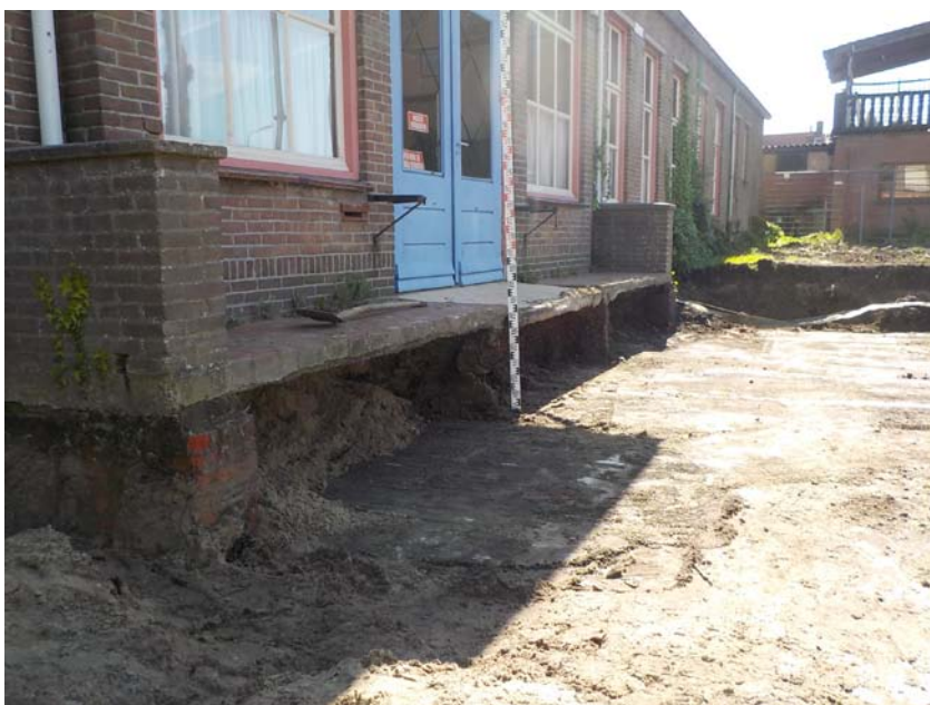
Foto 8. Muurtjes en vloer voorzijde gebouw, er onder is zoveel mogelijk grond weggehaald
