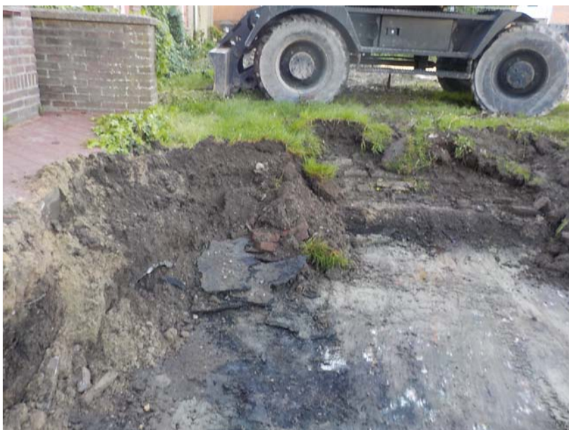
Foto 6. Ontgraving PAK verontreiniging aan voorzijde gebouw, op 0,7 m-mv betonvloer
