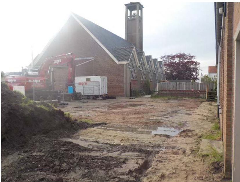
Foto 1. Beginsituatie PAK ontgraving achterzijde gebouw
