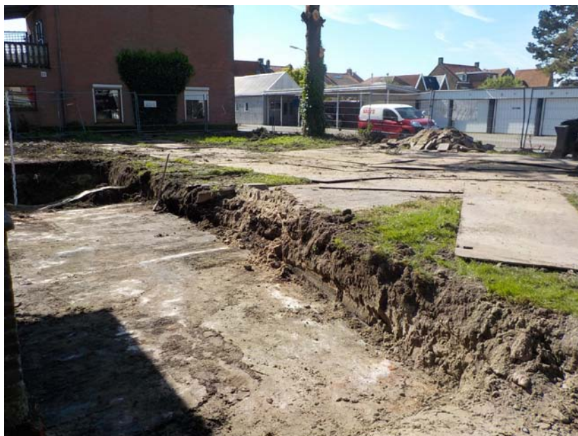
Foto 6. Eindsituatie ontgraving PAK verontreiniging aan voorzijde gebouw
