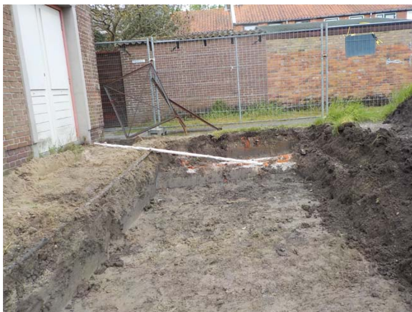
Foto 4. Ontgraving achterzijde gereed
