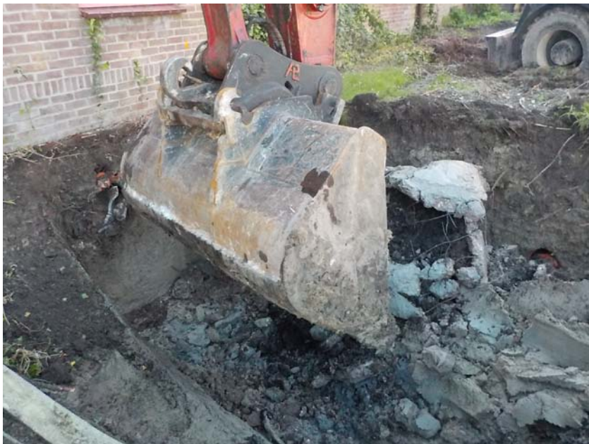
Foto 7. Verwijdering oude septictank
