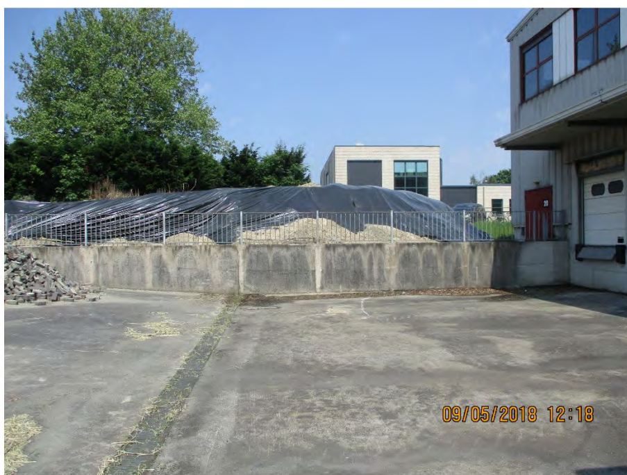
Figuur 8 Deelpartij 2, achter keerwand, gezien in noordelijke richting.
