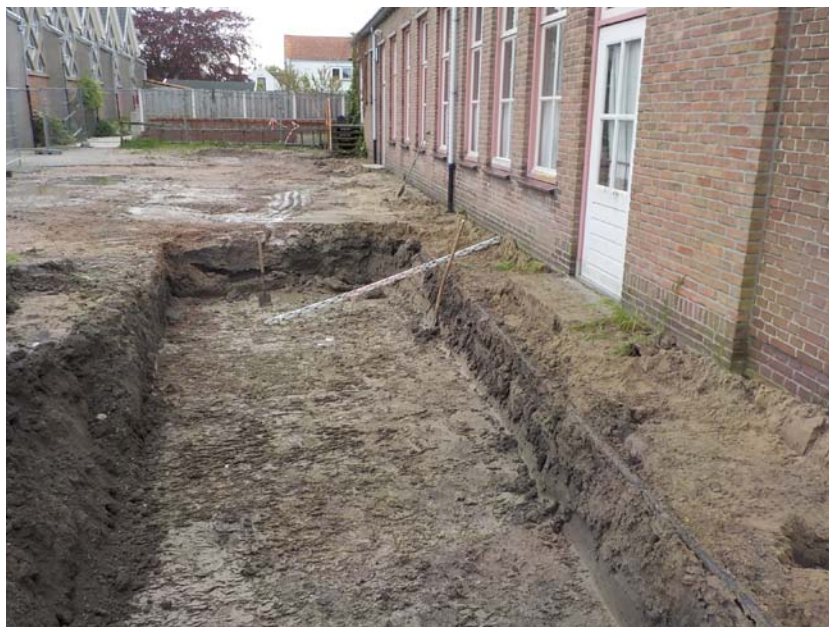
Foto 3. Ontgraving achterzijde gereed
