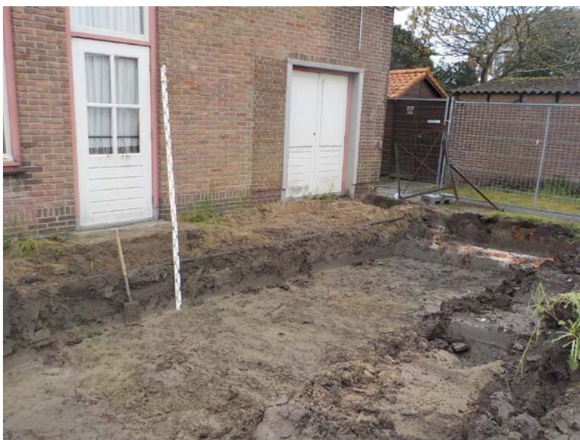
Foto 2. Ontgraving achterzijde, tegen het gebouw is een strook niet ontgraven vanwege een gasleiding
