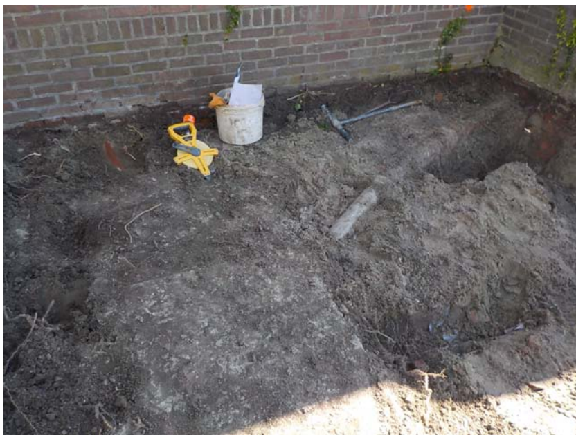
Foto 9. Inspectieput en leidingwerk voorzijde gebouw
