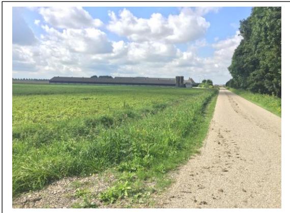
De Margarethaweg met op de achtergrond de bestaande kippenstal. De nieuwe komt ervoor.
