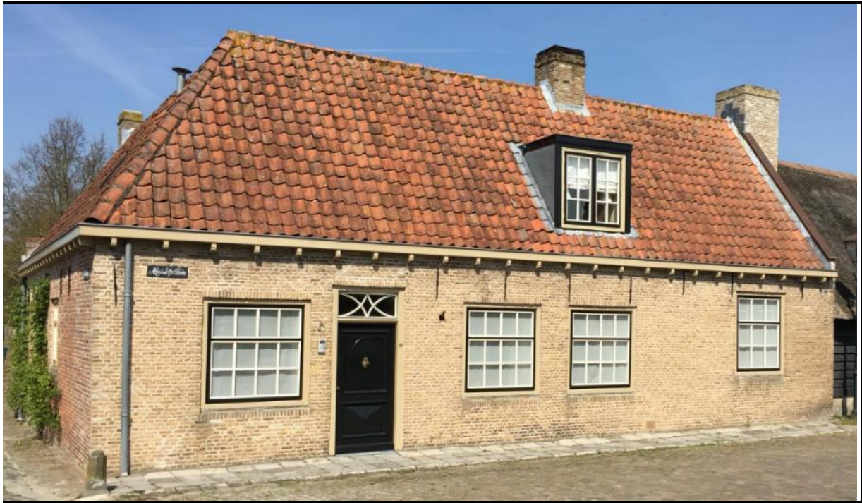
Figuur 2: Foto huidige situatie woning Marktplaats 10 (Google Maps 2017)
