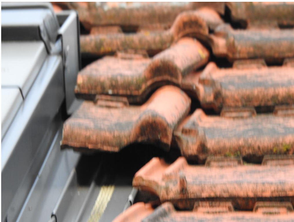
Foto 3. Binnenzijde schuur, kierende dakpannen.
