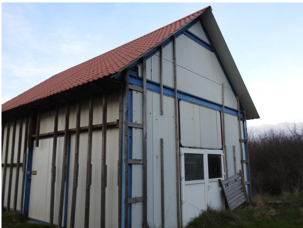
Foto 4. Te slopen schuur.
