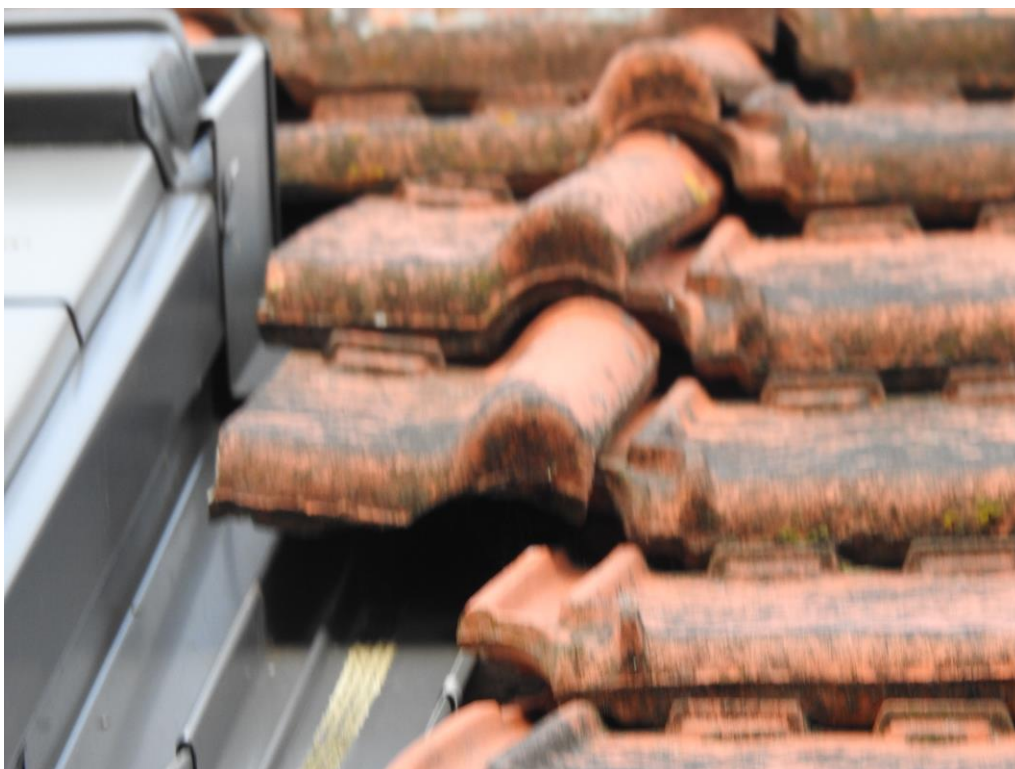
Foto 3. Binnenzijde schuur, kierende dakpannen.
