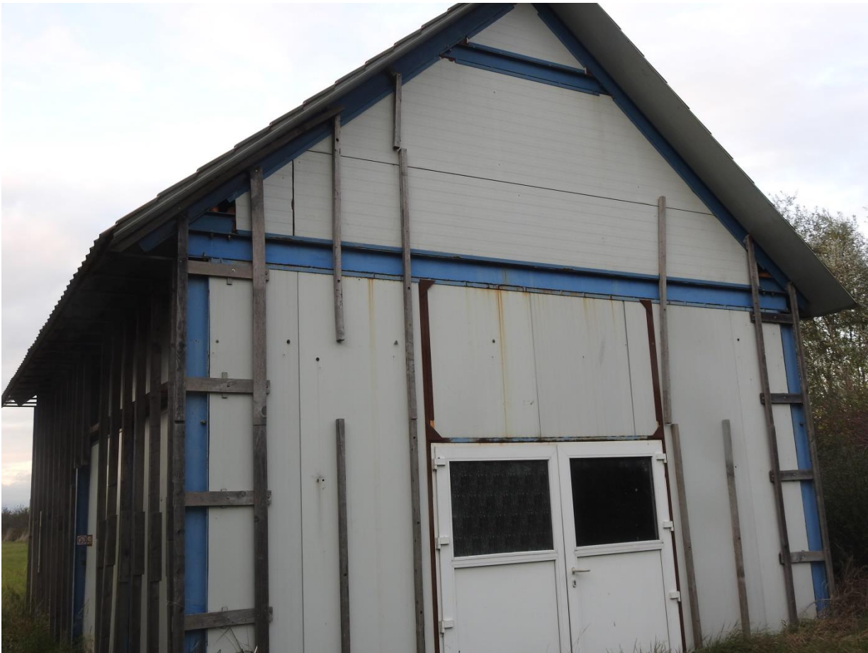
Foto 2. Te slopen schuur.
