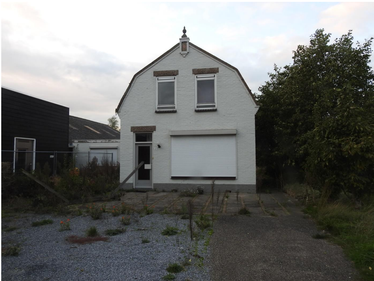
Foto 1. Te slopen woonhuis.
