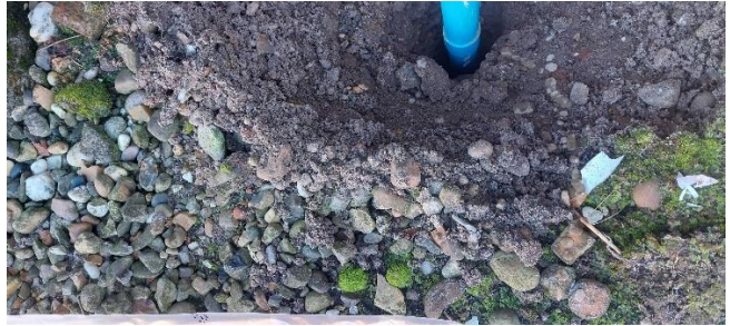
Doorzetten boring 301b naar 2,0 m-mv
