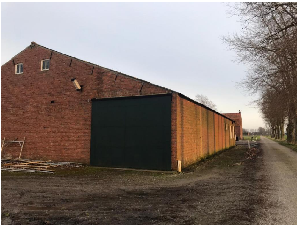
Foto 2. Damwand profiel (te glad voor vleermuizen).
