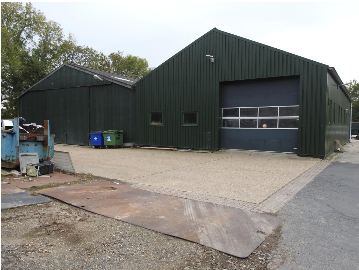
Foto 1. Te slopen bebouwing.
