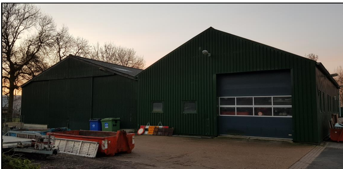
Figuur 5: Foto plangebied nieuwe locatie Nieuwstraat 46A Sluis
