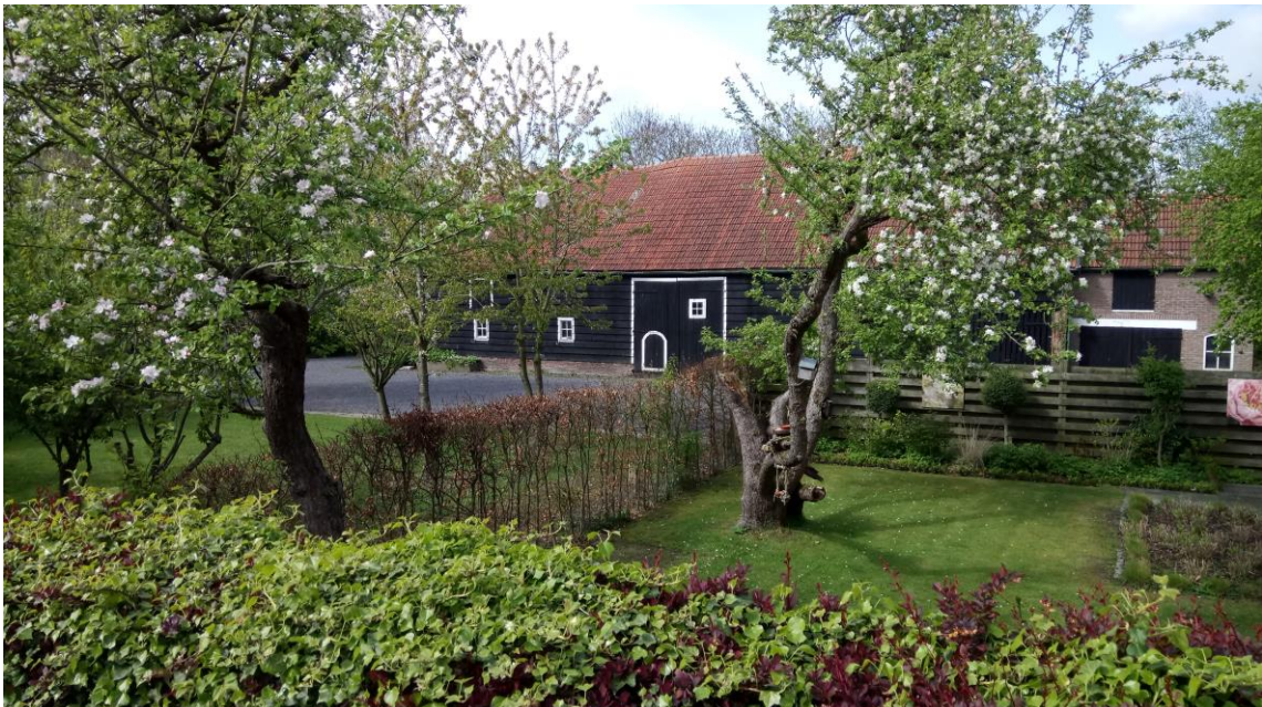
Figuur 4: Voorzijde schuur vanaf de Nieuwstraat
