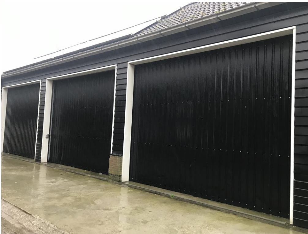
Foto 1. Buitenzijde van het gebouw.
