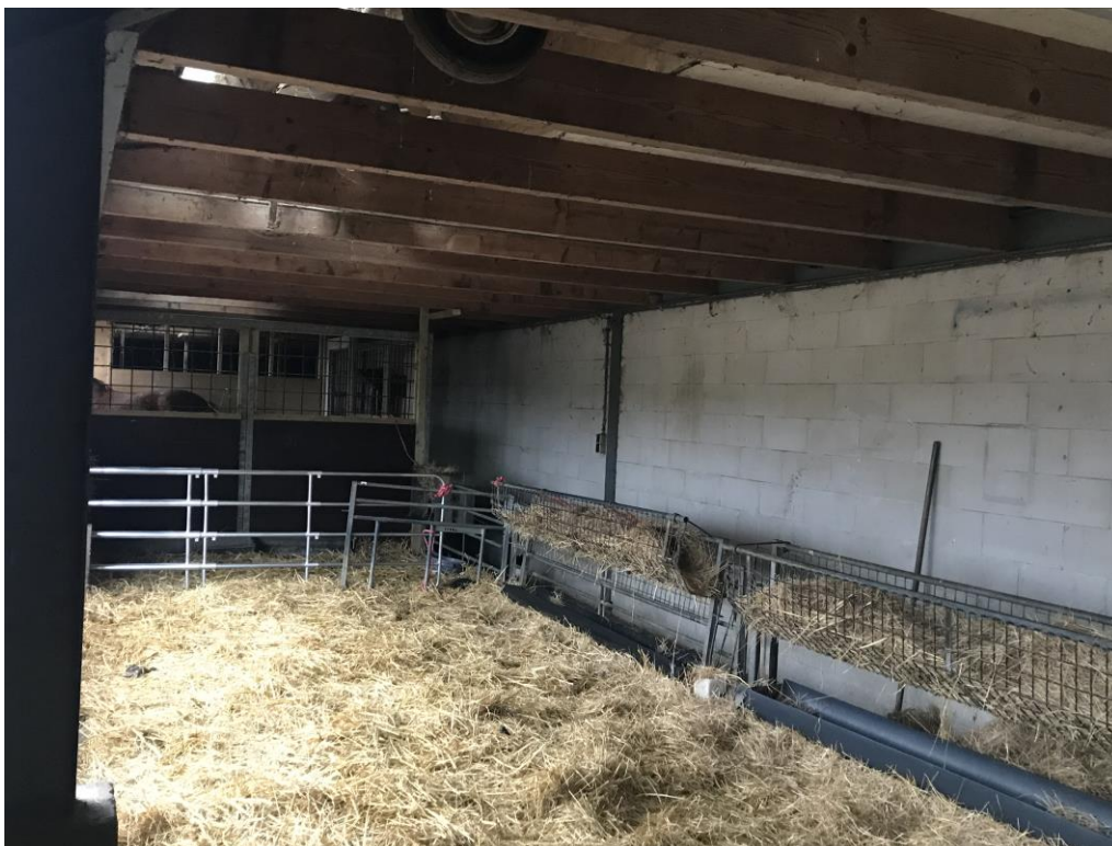
Foto 2. Binnenzijde van het gebouw.
