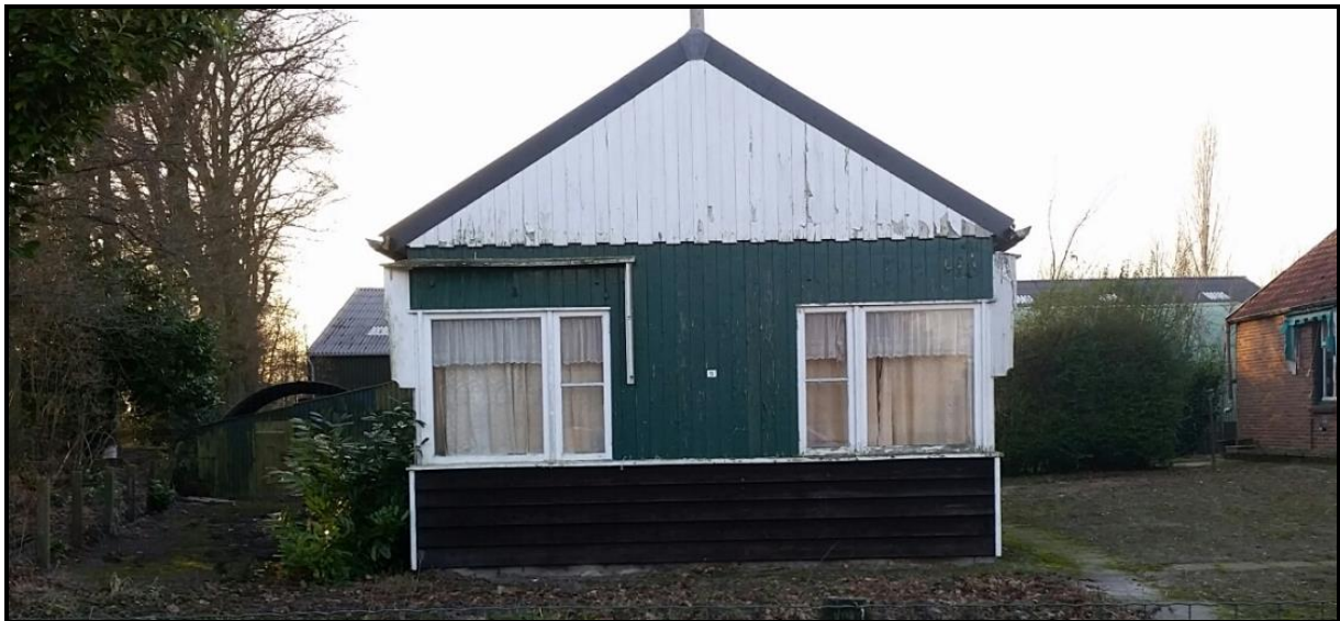
Figuur 3: Huidige te slopen woning (foto 2017).
