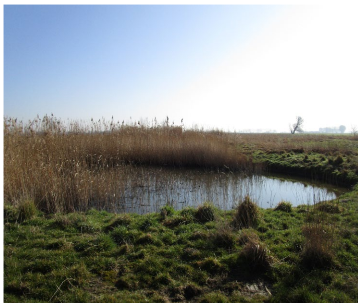
Helofytenfilter op het terrein.
