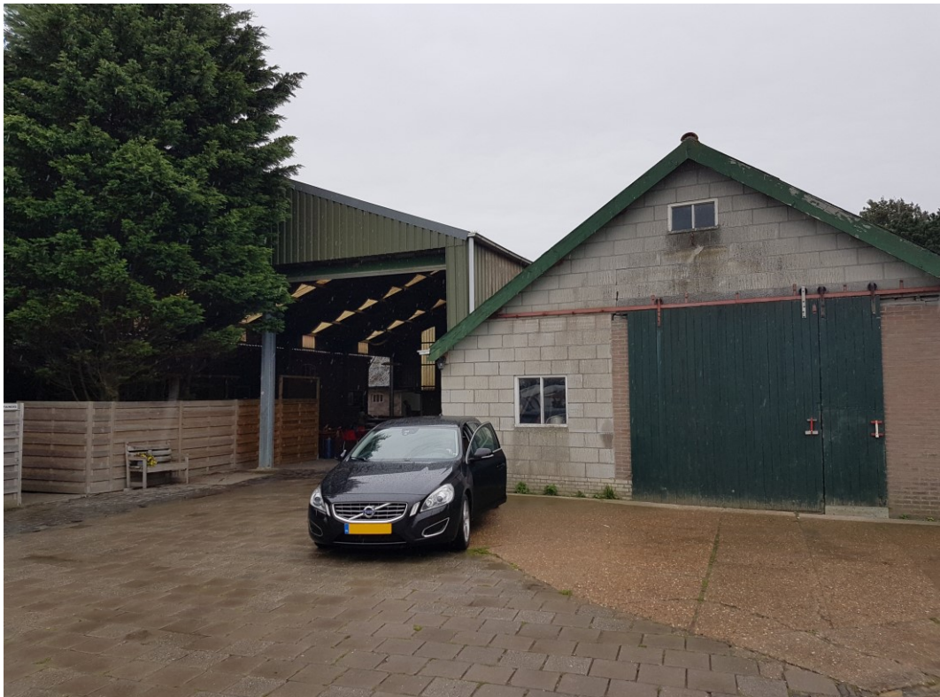
Foto 1. Te slopen schuren
