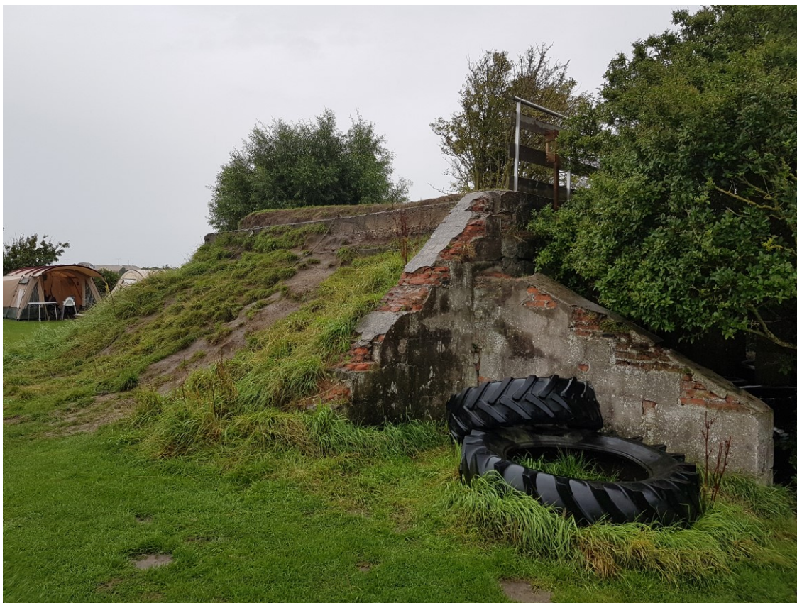
Foto 6. Te slopen bunker
