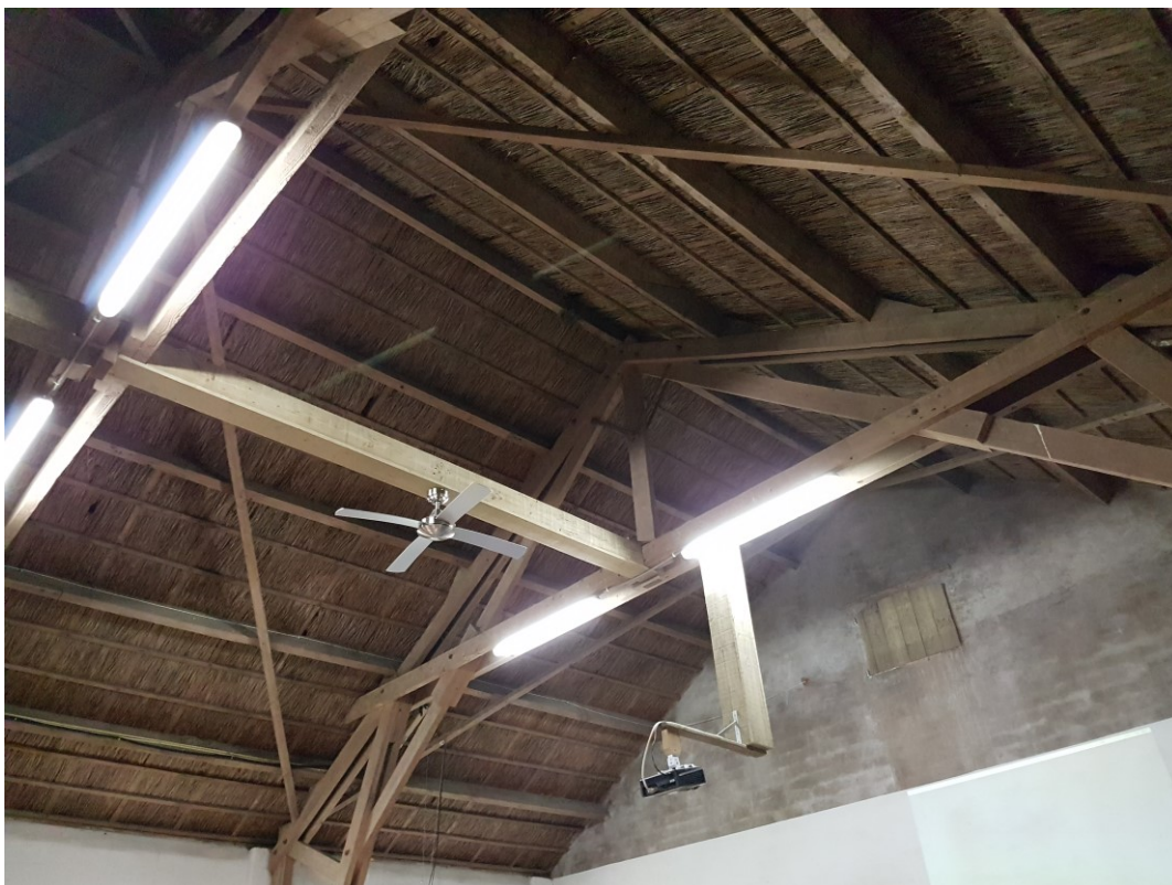
Foto 2. Binnenzijde van een van de te slopen schuren
