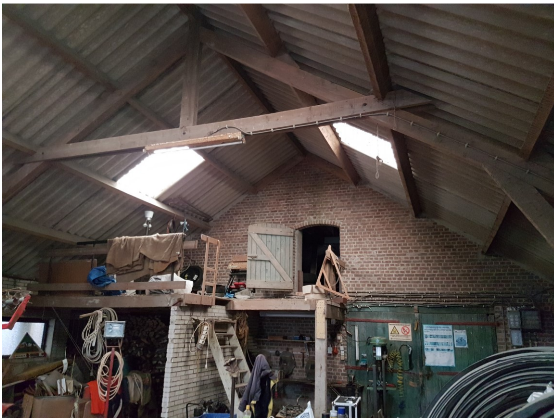
Foto 3. Binnenzijde van een van de te slopen schuren met op de achtergrond het luik naar de ruimte waar de afgebeten nachtvindervleugels zijn vastgesteld.
