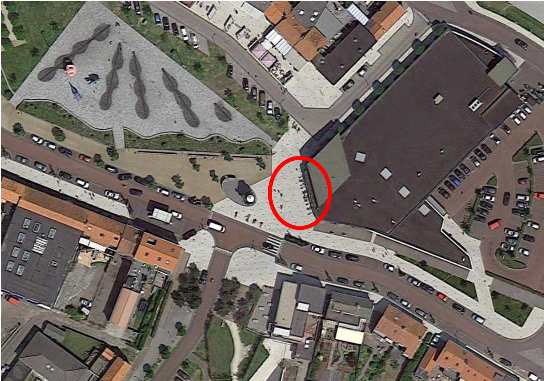
Afbeelding 5 Bestaande situatie plangebied.
