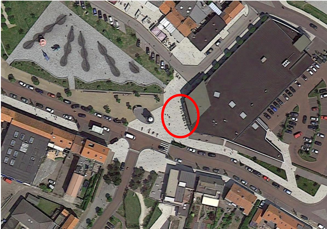
Afbeelding 5 Bestaande situatie plangebied.
