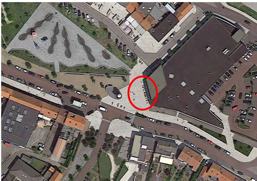
Afbeelding 5 Bestaande situatie plangebied.
