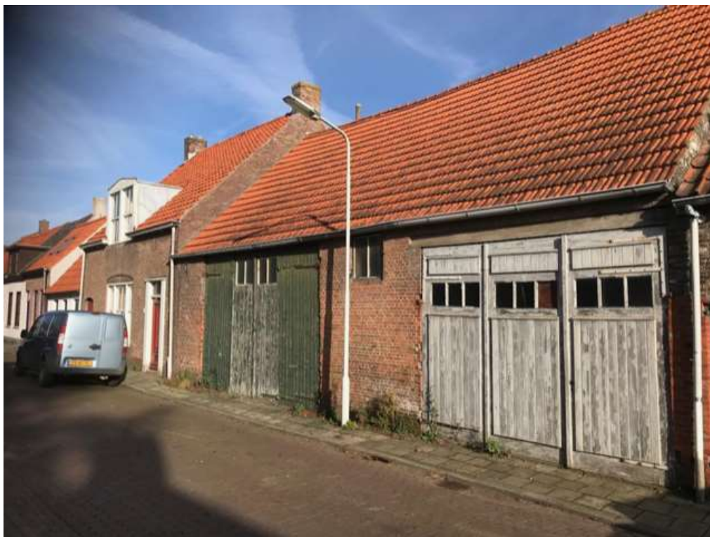
Foto 1. Buitenzijde van het gebouw.
