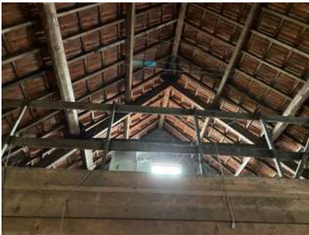
Foto 2. Binnenzijde van het gebouw.
