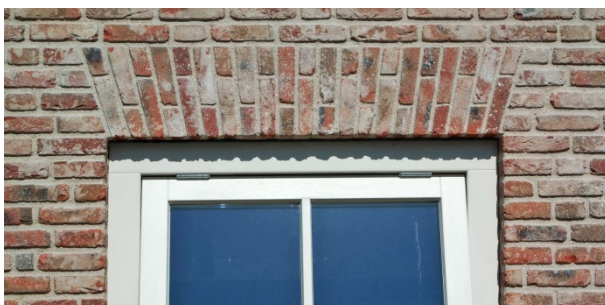
Rollaag boven ramen en deuren begane grond
