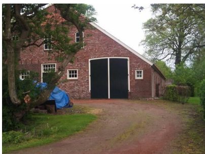
Garage onderdeel hoofdbouwmassa
