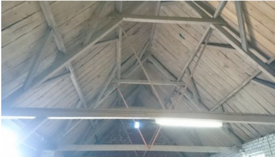
Interieur van de schuur, zicht op het dak.
