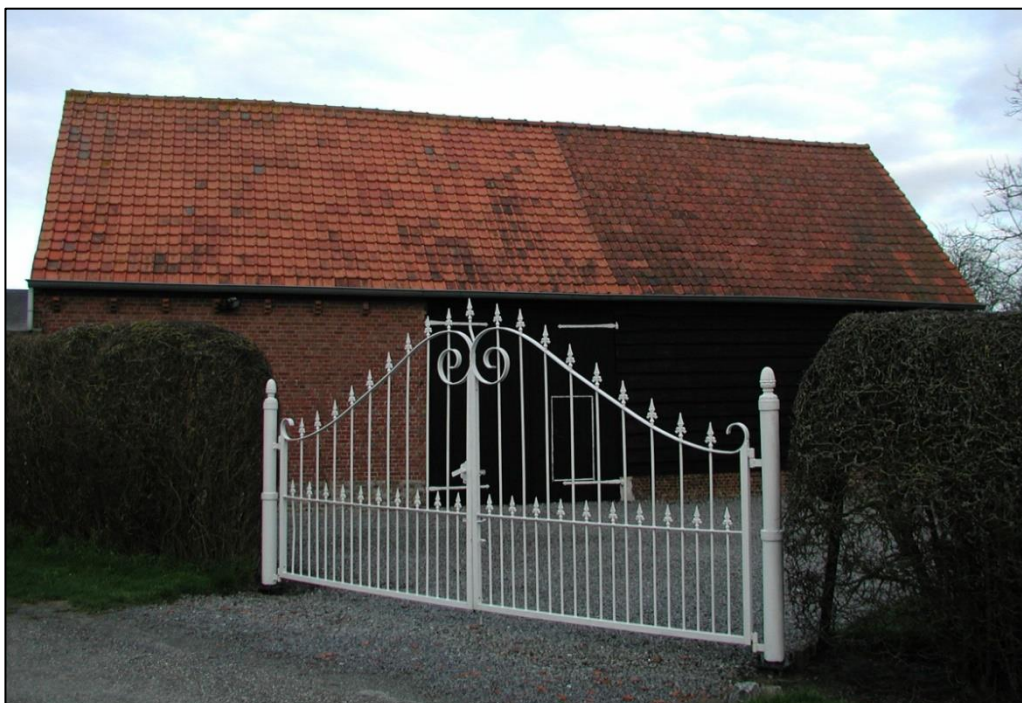
Foto van de schuur gemaakt vanuit de Ringdijk-Noord II. Het gebruik van diverse materialen bij herstelwerkzaamheden hebben de cultuurhistorische waarde van de schuur verloren laten gaan. Bron: rapport Cultuurhistoriekaart provincie Zeeland.
