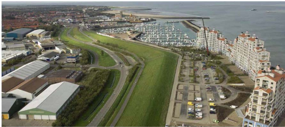
Figuur 12.5 Hoogbouw buitendijks: Port Scaldis, gezien vanuit de lucht. (bron: Masterplan)
