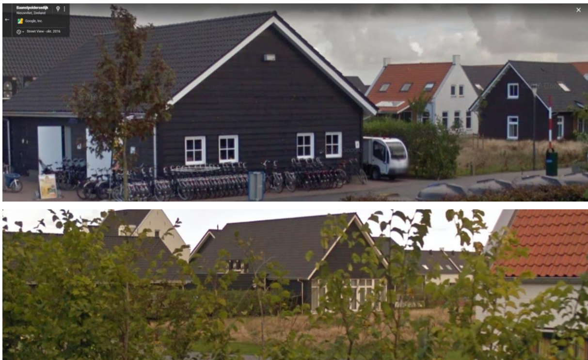
Afbeelding 9 Huidige landschappelijke inpassing vanaf de huidige fietsenverhuur (boven) en vanaf de weg (onder) (Bron: www.google.nl , d.d. 24.10.2017)
