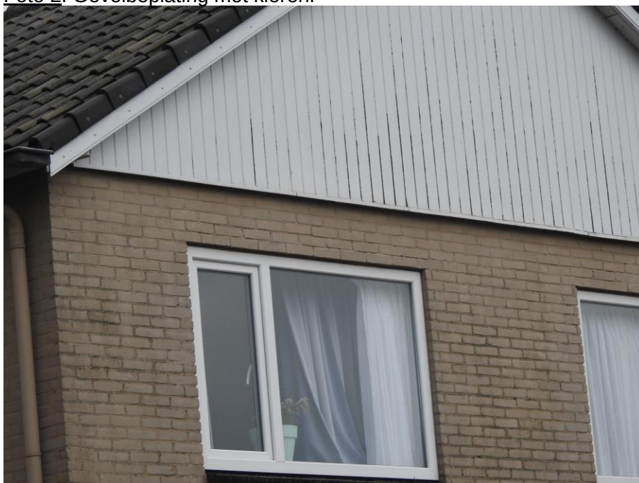
Foto 2. Gevelbeplating met kieren.
