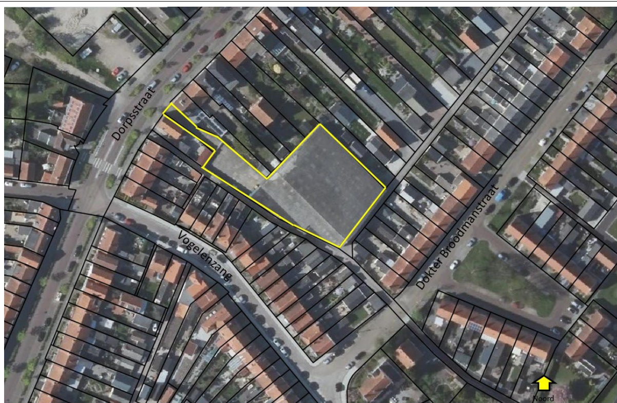
Figuur 2. Plangebied (luchtfoto 2016)
