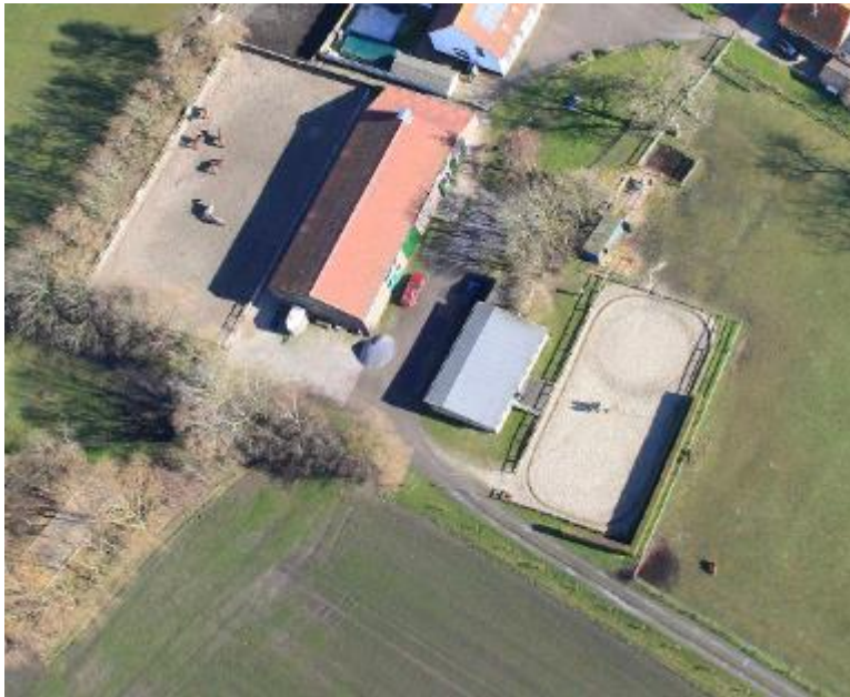
Figuur 3: Luchtfoto planlocatie
