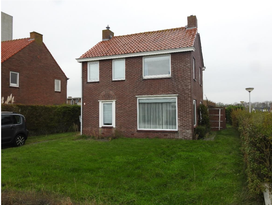
Foto 1. Te slopen bebouwing.
