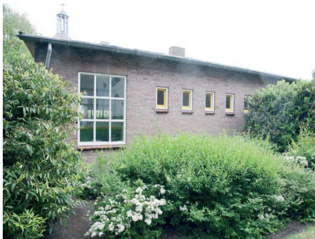
Impressie achterzijde kleuterschooltje, met een gedeelte van de beplanting op het terrein.
