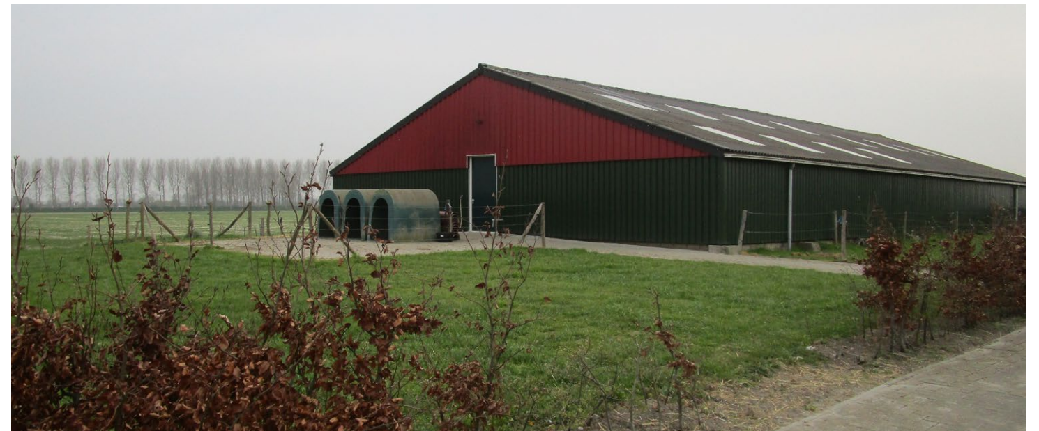
De te amoveren loods aan de oostzijde van het perceel.
