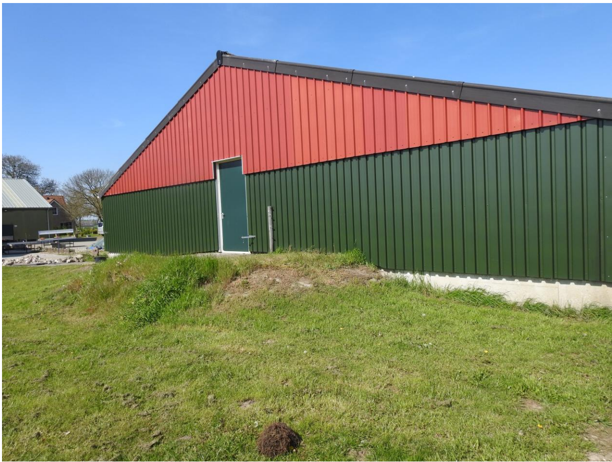
Foto 1 Te slopen bebouwing.
