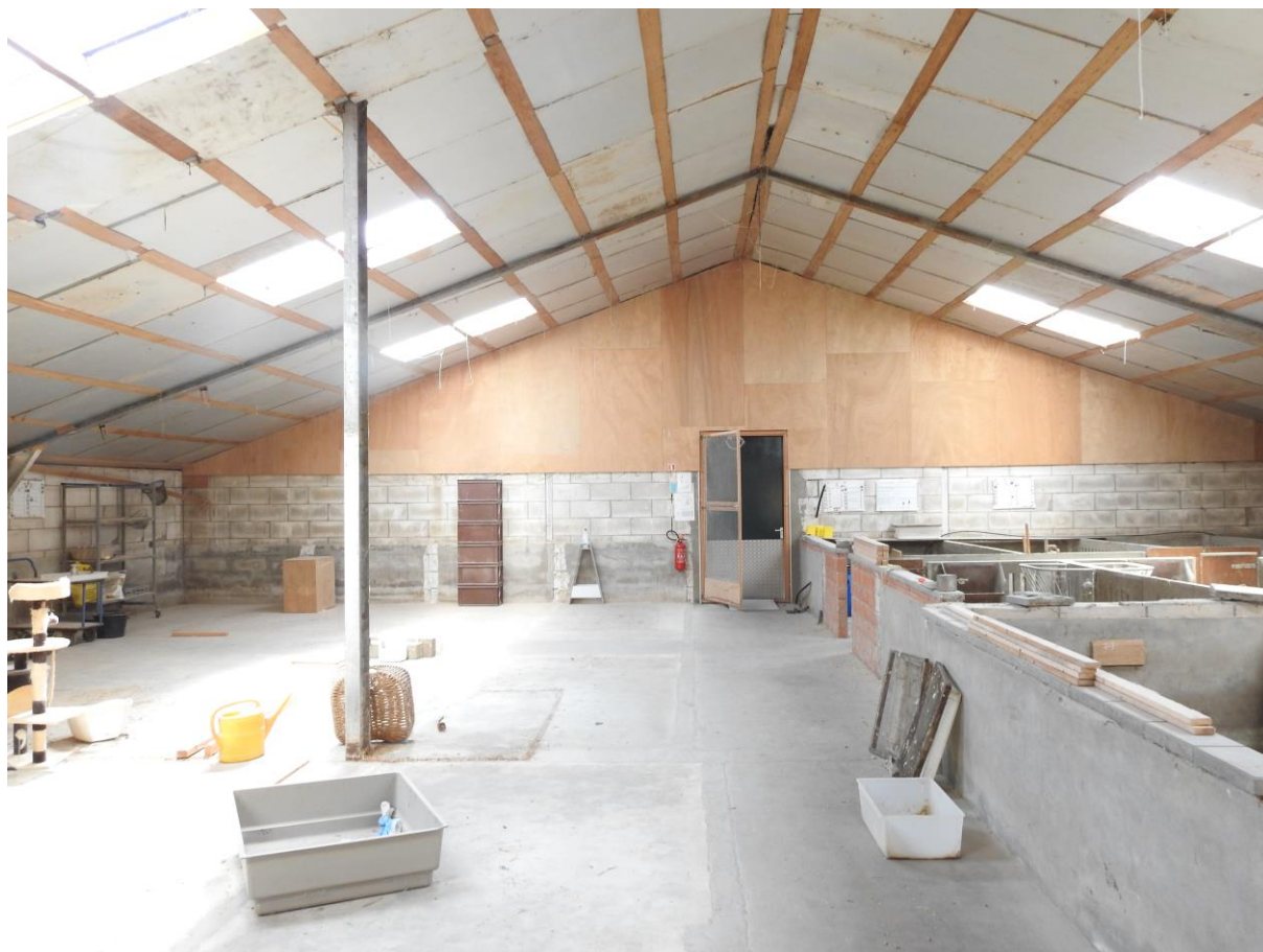
Foto 2. Te slopen bebouwing.
