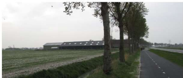
Zicht vanaf de Watervlietseweg op de loods.
