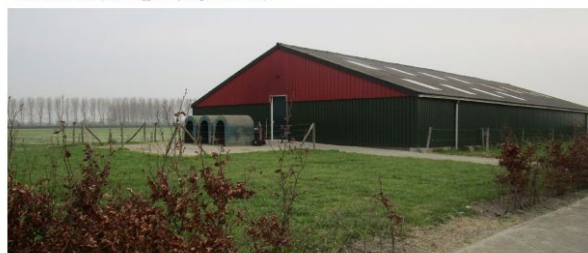
De te aanmerken loods aan de oostzijde van het perceel.
