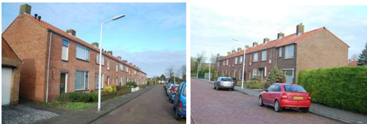
Foto's 1 en 2: Te slopen huizen aan de Crijnssenlaan en Banckertlaan (Huismus)
