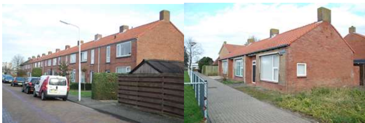
Foto's 8 en 9: Te slopen huizen aan de Evertsenlaan en de Vijverlaan (Vleermuizen)
