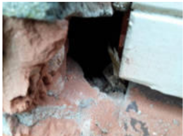
Geen asbestverdachte materialen in spouwen
