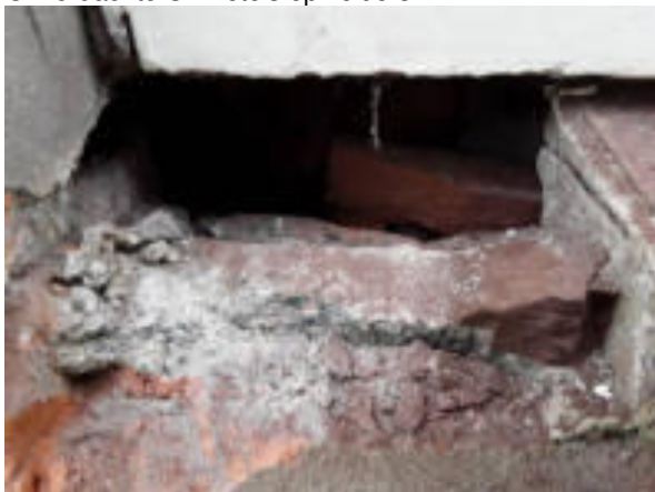
Geen asbestverdachte materialen in spouwen
