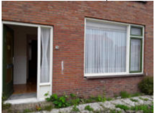
Geen asbestverdachte materialen in spouwen
