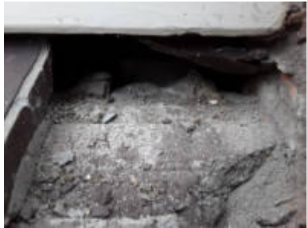
Geen asbestverdachte materialen in spouwen
