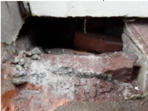
Geen asbestverdachte materialen in spouwen
