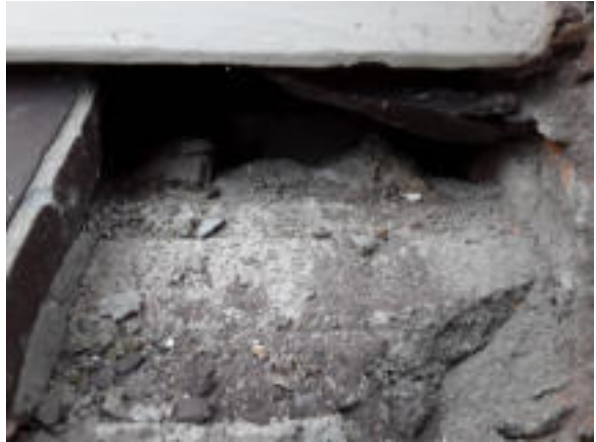
Geen asbestverdachte materialen in spouwen
