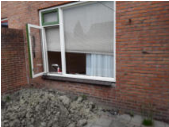
Geen asbestverdachte materialen in spouwen
