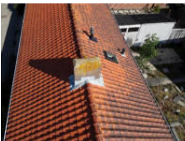
Op de schoorstenen zijn geen verdachte materialen aangetroffen.
