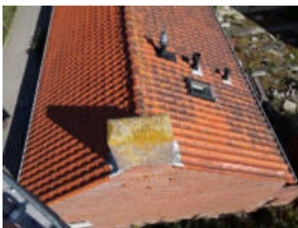
Op de schoorstenen zijn geen verdachte materialen aangetroffen.
