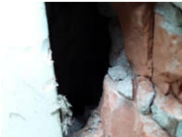
Geen asbestverdachte materialen in spouwen
