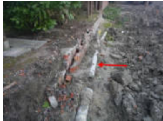
Foto 8 | Foto voor bron Riolering
