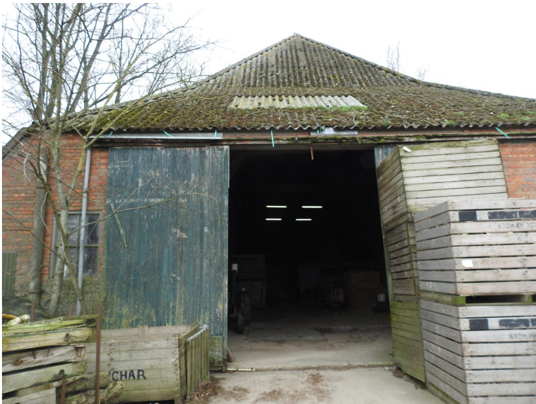
Foto 1. Buitenzijde te slopen schuur.
