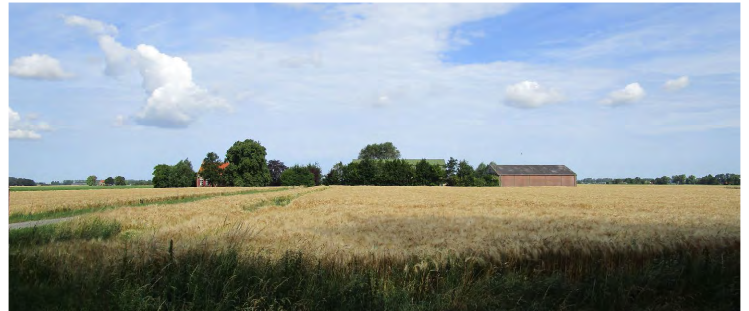
Zicht vanaf de weg richting het bestaande erf, de bestaande bebouwing ligt gedeeltelijk verscholen achter het aanwezige groen.
